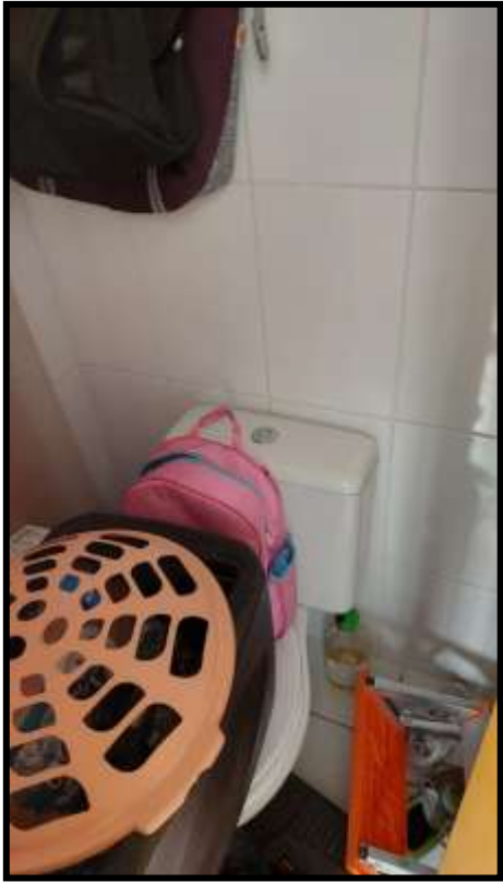
BANHEIRO DE EMPREGADA
